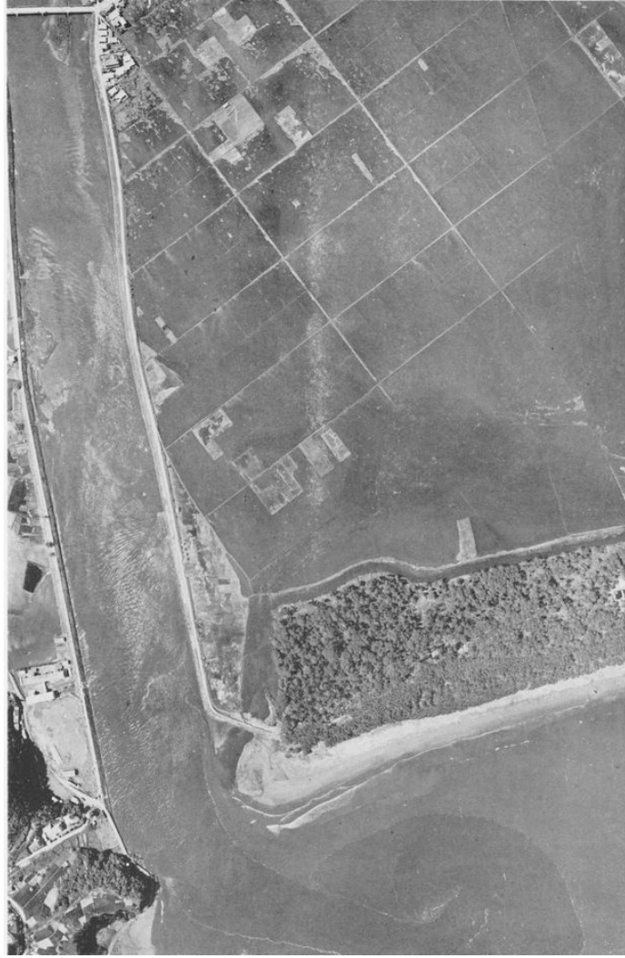
1960年5月24日：チリ津波直後の陸前高田市（建設省国土地理院，1961）
