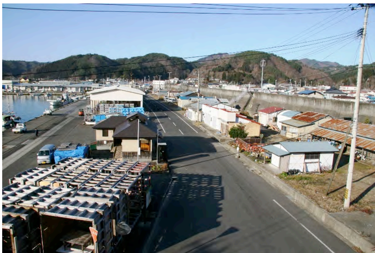
完成直後，防潮堤海側には漁具小屋以外の建物はなかったが，今は多くの家が建っていて災害が風化しつつあるように見える（宮古市田老）（山村，2011）
