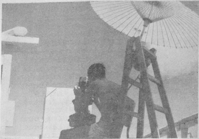
晴れた日は番ガサを陽よけに測風経緯儀で約80分も気球を追って観測する。
