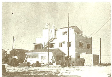
第16図 (ph. Yamada) 観測所本部、階下は 食堂と炊事場、階上が事務室、無線室、 一番上が観測室になっている。無線室 の天井にはヤモリがはりついていた。
